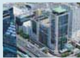
I-1 IIF 神戸地域冷暖房センター
