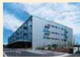
L-3 IIF 船橋ロジスティクスセンター
