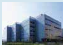
IIF 新砂データセンター (注)
