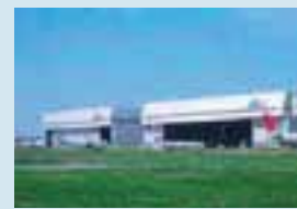
I-2 IIF 羽田空港メンテナンスセンター
