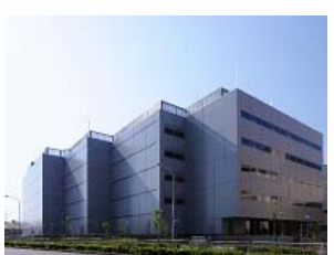
IIF 新砂 データセンター(注)
