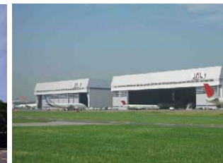
I-2 IIF 羽田空港 メンテナンスセンター
