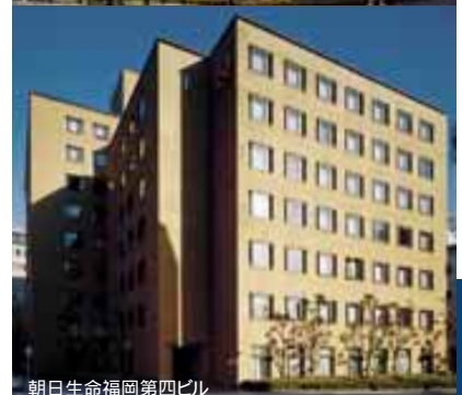
朝日生命福岡第四ビル
