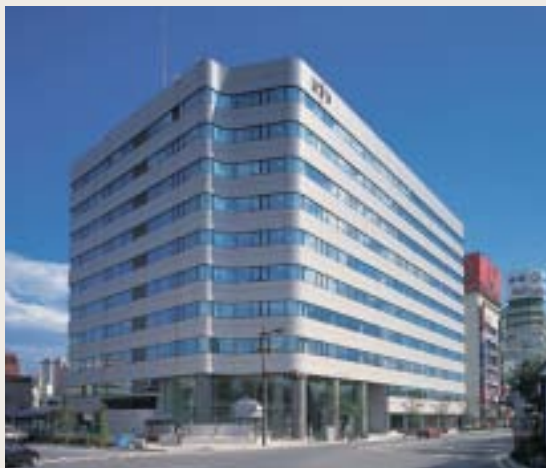
48 NBFユニックスビル
