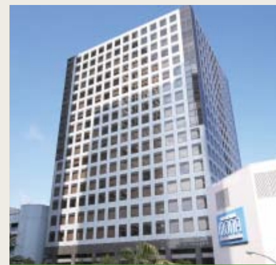
43 新浦安センタービルディング
