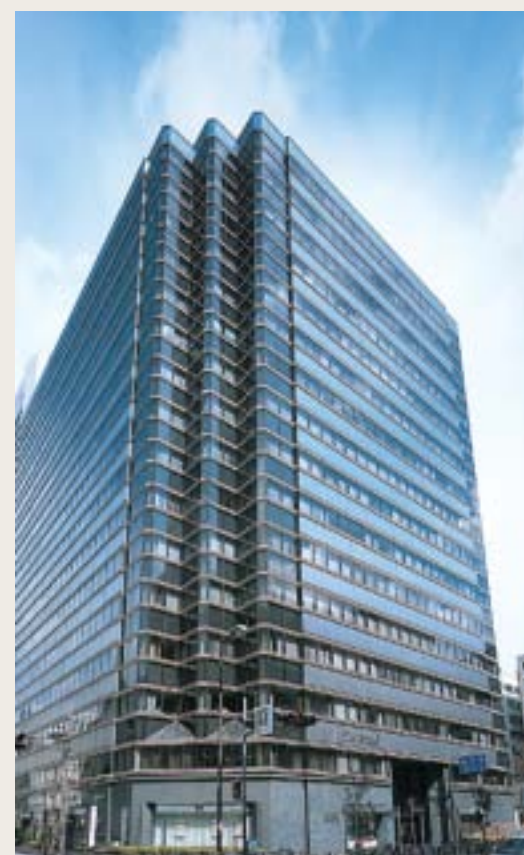
54 堺筋本町センタービル
