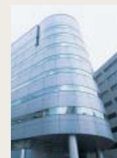
60 NBF博多祇園ビル
