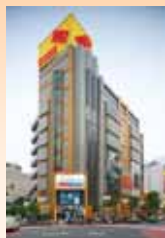
JPR渋谷タワーロードビル
