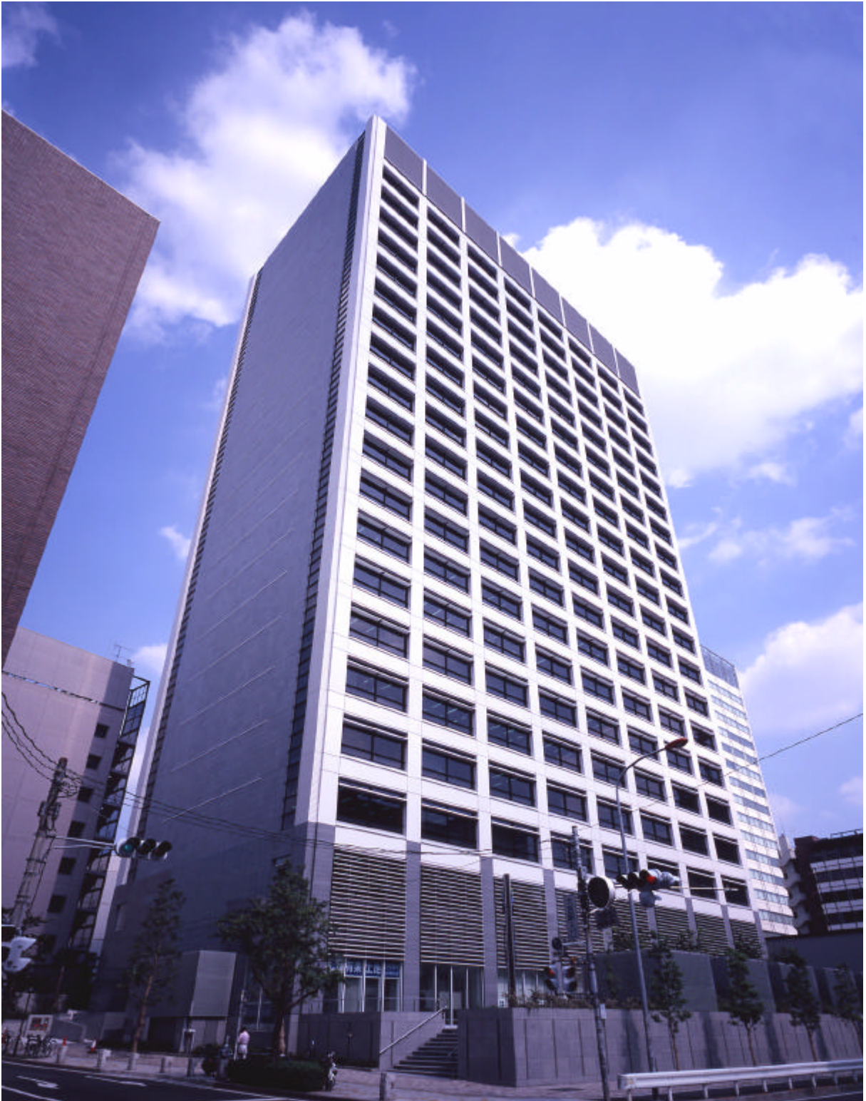
【参考資料 3】シーノ大宮ノースウイングの外観写真
