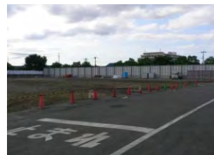
【西側倉庫群 解体後の様子】
