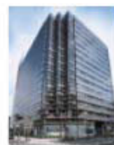
堺筋本町センタービル
