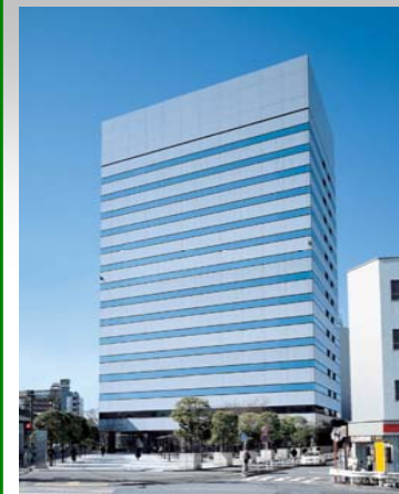
Ⅲ-5 川崎日進町ビルディング Kawasaki Nissincho Building
