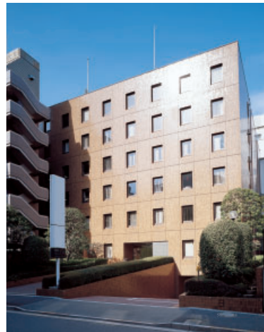
I-5 第36興和ビル No.36 Kowa Building
