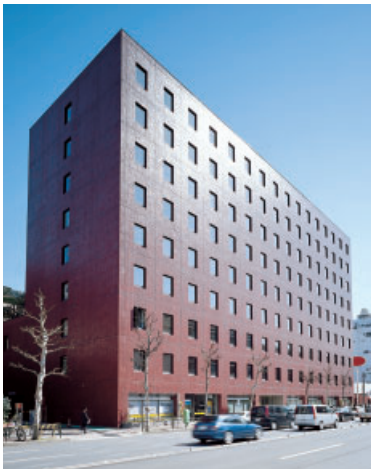
I-4 第32興和ビル No.32 Kowa Building
