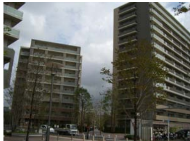
プロシード西新井・オザリア棟
