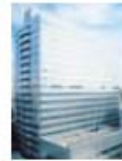
30 横浜STビル
