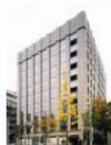
広小路東栄ビル
