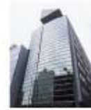
住友電設ビル
