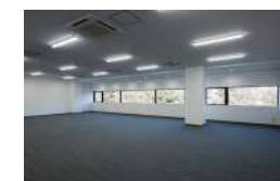
事務所の照明・電源の確保
