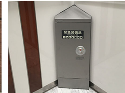
横浜プラザビル
