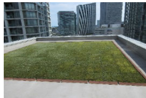
横浜プラザビル(屋上部分)
