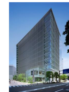
横浜プラザビル
