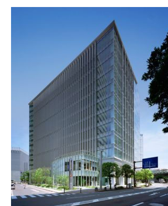
横浜プラザビル*
