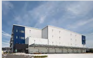
ロジポート柏沼南
