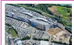
イオンモール熊本 復旧工事(注)
