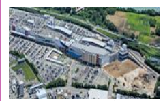
イオンモール熊本 復旧工事(注)
