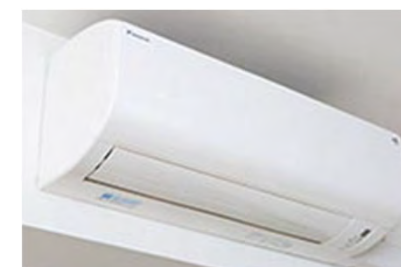
空調設備の更新
