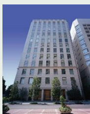
淀屋橋フレックスタワー
