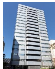
横浜STビル (神奈川県横浜市)
