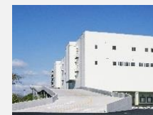
上層階へのスロープ
