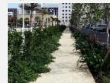
外構緑化・透水性舗装
