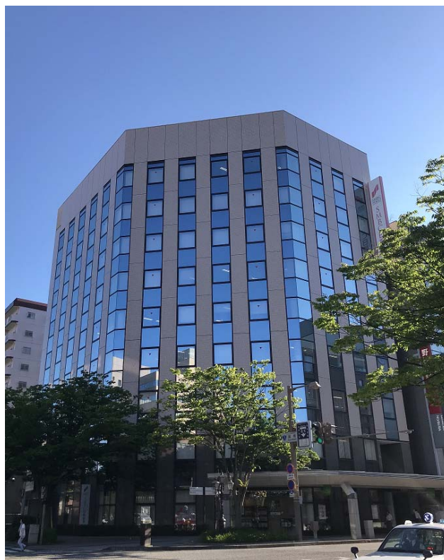
(参考) 大同生命新潟ビル外観写真
