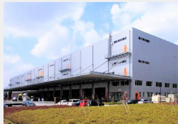
IIF野田ロジスティクスセンター
