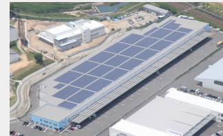
IIF鳥栖ロジスティクスセンター
