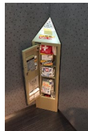
ELV内 防災キャビネット
