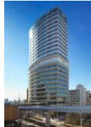
浜離宮インターシティ
