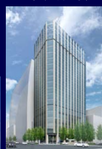
日鐵日本橋ビル 建替計画 2019年3月竣工予定
