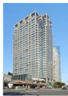
日石横浜ビル
