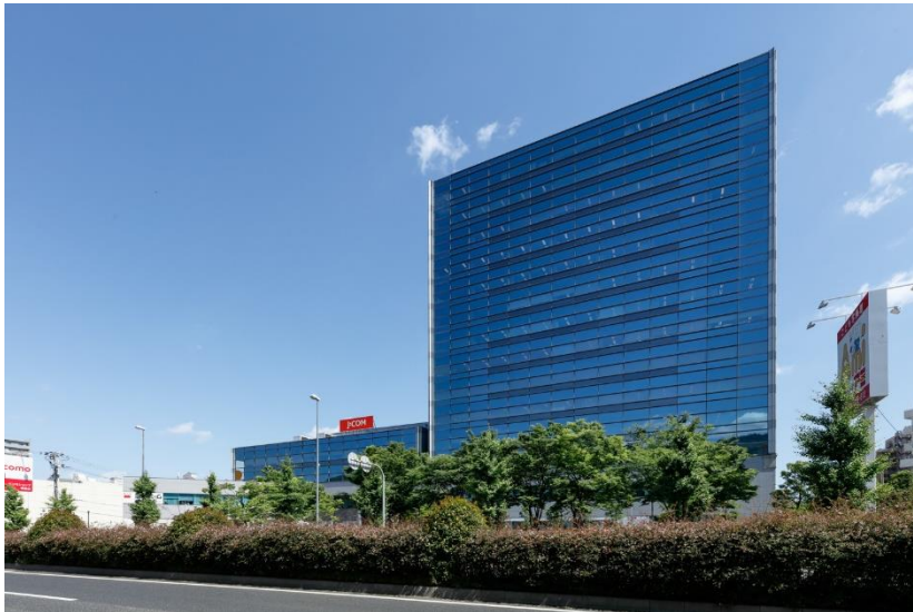
参考資料1 取得資産が含まれる既存部分（建物）の外観写真及び地図 OFC-12 東神戸センタービル
