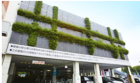
太陽光パネル
