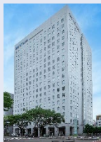
仙台MTビル
