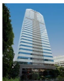
紀尾井町ビル
