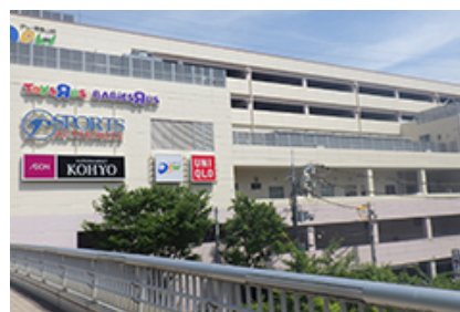
デュー阪急山田の外壁工事
