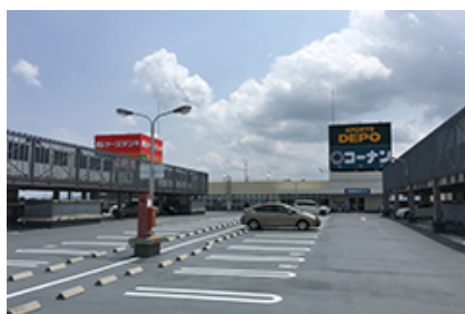
高槻城西ショッピングセンターの屋上防水工事
