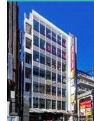
商A-7 FUNDES水道橋
