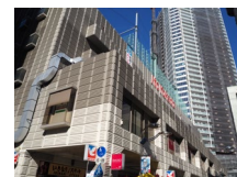
JPR武蔵小杉ビル 外壁改修
