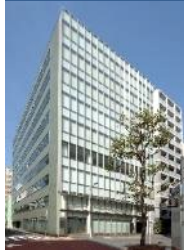
事A-20 JPR日本橋堀留ビル
