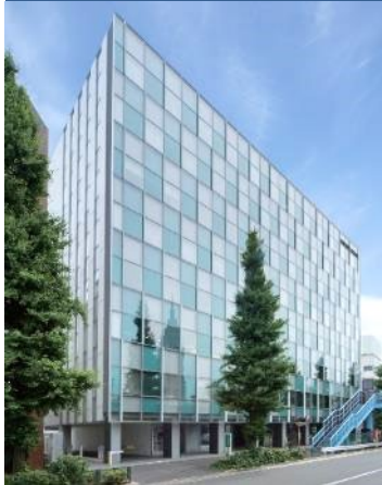
事A-21 JPR千駄ヶ谷ビル
