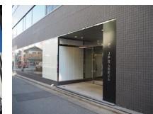
JPR人形町ビル エントランス改修
