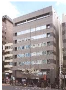
JPR市ヶ谷ビル
