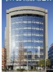
事A-15 南麻布ビル
