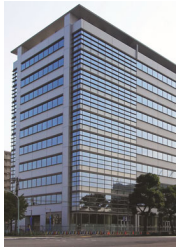
A-18 晴海センタービル
