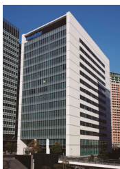
A-41 大崎フロントタワー
