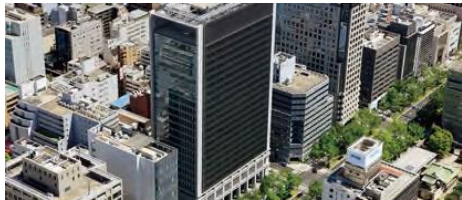
従来からのオフィスの中心地であり、大阪市のメインストリートである御堂筋沿いに立地
