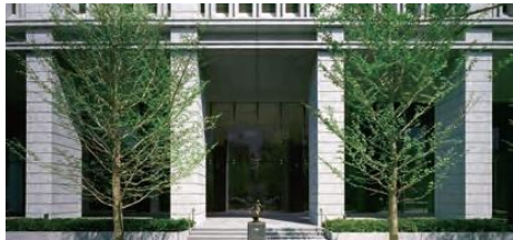
2011年竣工の開放感と重厚感のあるビル
