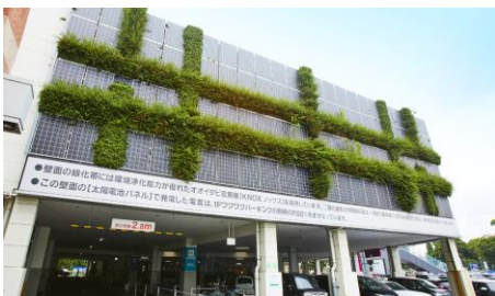
太陽光パネル
