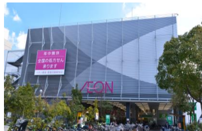
外壁塗装工事
