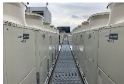
個別空調への更新工事実施 (Daiwa銀座ビル)
