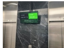
デジタルサイネージ設置 (Daiwa銀座ビル)
