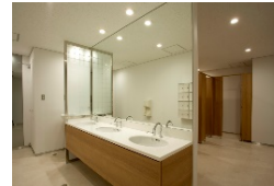
洗面器具の改修工事実施 (Daiwa月島ビル)
