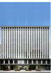
B-19 四条烏丸センタービル
