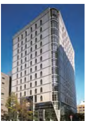
B-22 堺筋本町ビル
