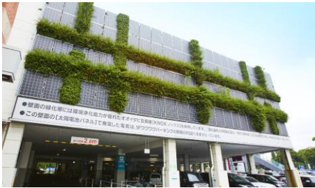
太陽光パネル
