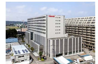
いちご富山駅西ビル
