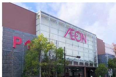
外壁塗装工事
