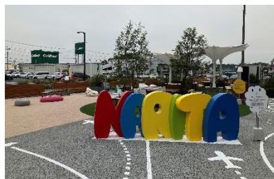
テラス新設工事
