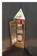
ELV内 防災キャビネット
