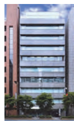
KDX新日本橋駅前ビル
