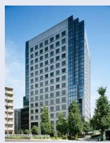
大崎MTビル
