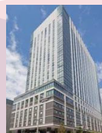
コードヤード・バイ・マリオット 東京ステーション
