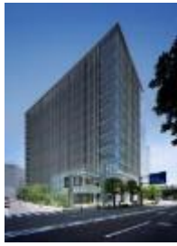
横浜プラザビル (神奈川県横浜市)
