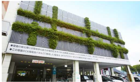
太陽光パネル
