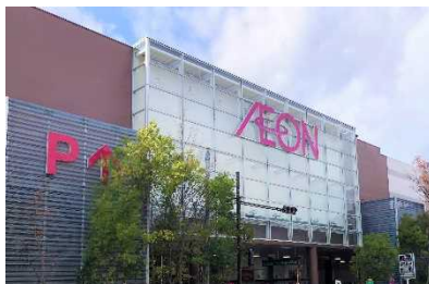
外壁塗装工事
