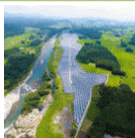
日光市の太陽光発電所
