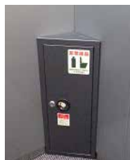
Daiwa麻布テラス EV内
