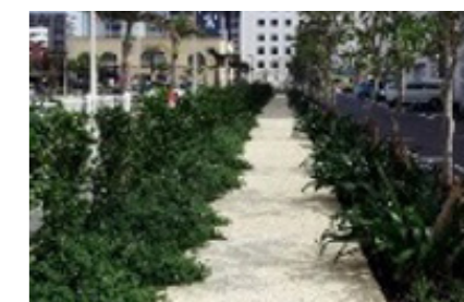
外構緑化・透水性舗装
