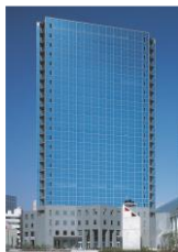
A-26 シーバンスS棟
