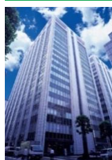
A-11 有楽町電気ビルディング
