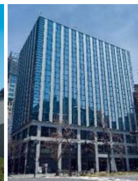
御堂筋MTRビル
