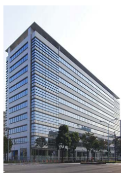
晴海センタービル (東京都中央区)
