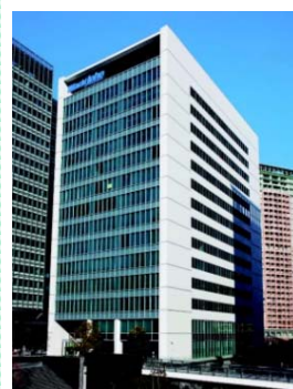
大崎フロントタワー (東京都品川区)
