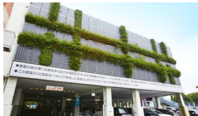
太陽光パネル
