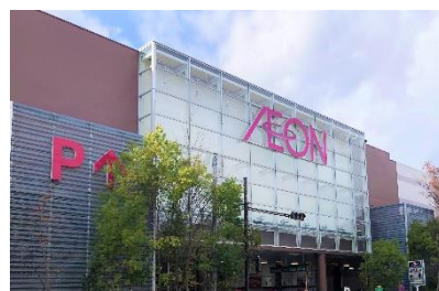
外壁塗装工事
