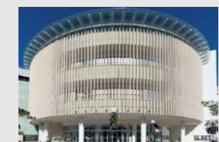
太陽光発電設備
