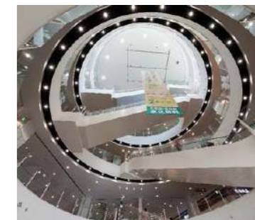
LED照明にした館内通路
