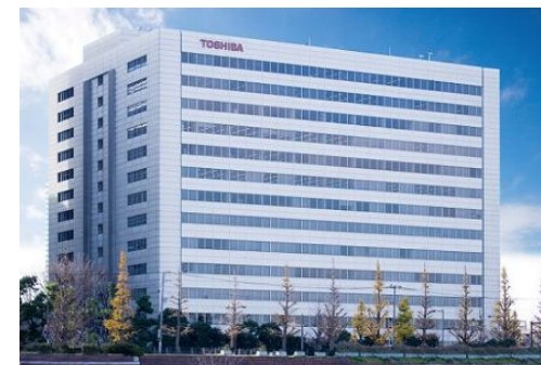
川崎東芝ビル（神奈川県川崎市）
